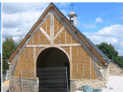
Pignon Ouest état restauration 2008
