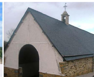
Pignon Ouest , état 2009
